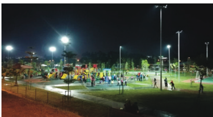
Sistem pencahayaan yang baik dapat menggalakkan pengguna untuk beriadah pada waktu malam
