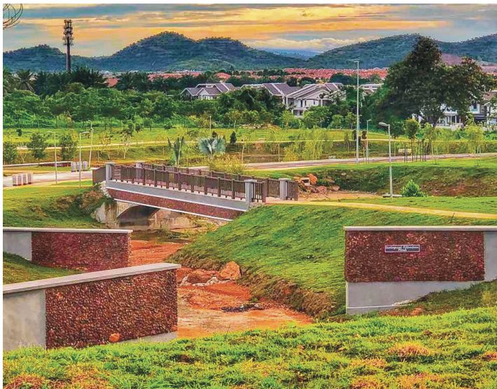
Dry creek antara elemen yang berfungsi sebagai laluan air [direct water runoff] ketika musim hujan
