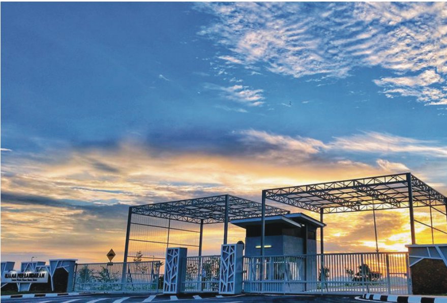
Pintu gerbang dengan rekabentuk moden dari kombinasi brick dan mild steel
